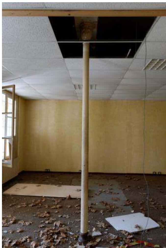
Figure 99 : Rive gauche, corps central, colonnette en fonte au premier étage. Photo. J. Defillon, 2012.
