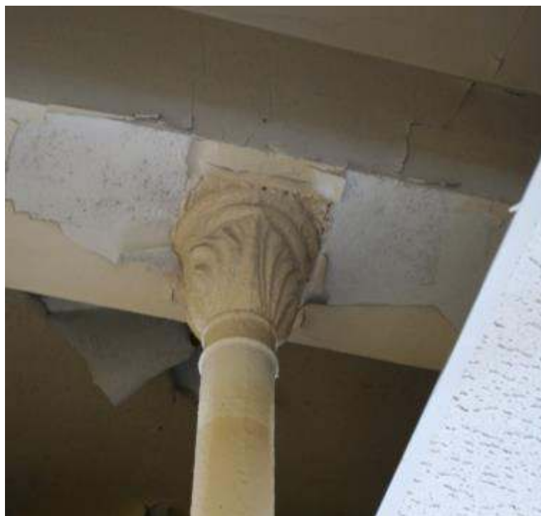
Figure 100 : Rive gauche, corps central, colonnette en fonte au premier étage, détail. Photo. J. Defillon, 2012.
