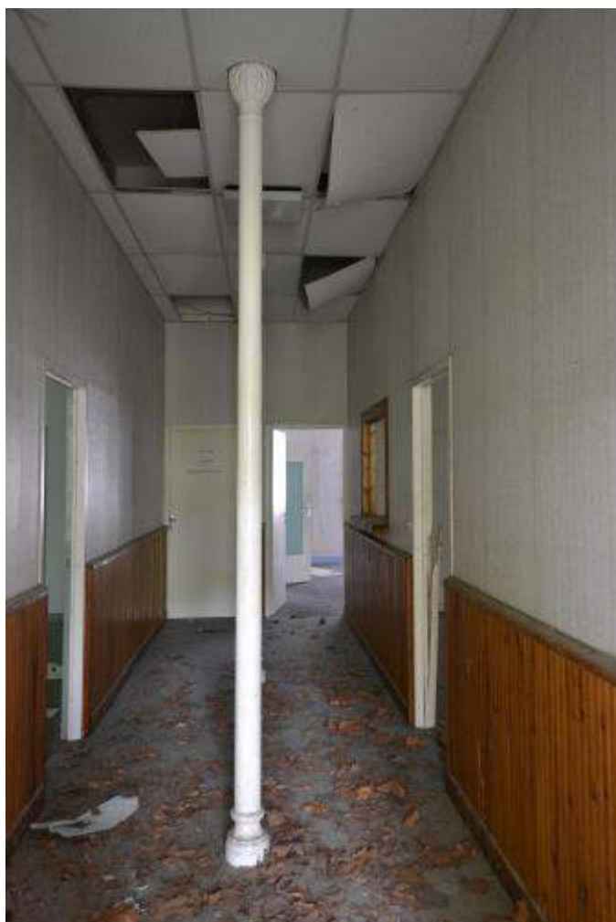
Figure 98 : Rive gauche, corps central, colonnette en fonte au premier étage. Photo. J. Defillon, 2012.
