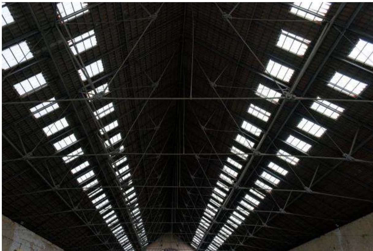
Figure 128 : Rive droite, manège : charpente métallique avec fermes à la Polonceau. Photo. J. Defillon, 2012.
