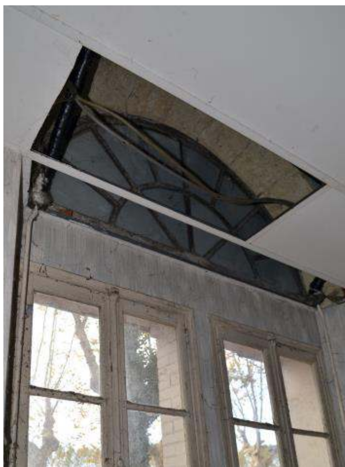
Figure 131 : Rive droite, écurie 37, détail de l'imposte conservée d'une baie du rez-de-chaussée. Photo. J. Defillon, 2012.
